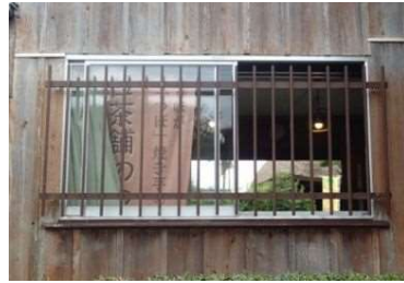
道路に面した窓には格子の設置
