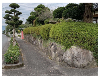
巨石積風の擁壁
