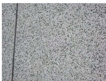
モルタル吹付・モルタル
