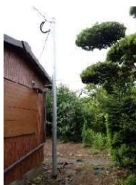
家の裏の引込柱
