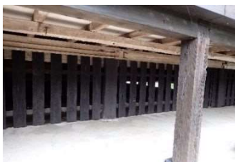
樹脂製基礎、格子柵の設置
