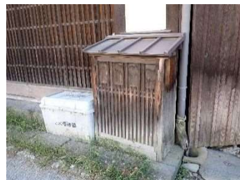
消防ホース収納庫
