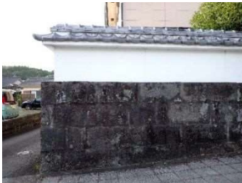
上段はコンクリート塀で下段は石垣の例（瓦葺き屋根付き）
