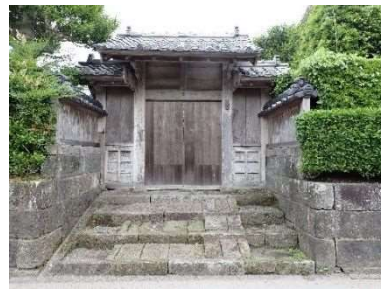
2 段及び袖壁の腕木門
