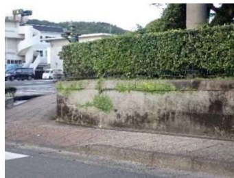
緑化フェンス
