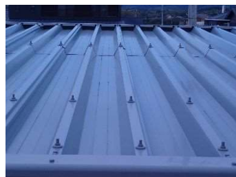
金属板折板葺
