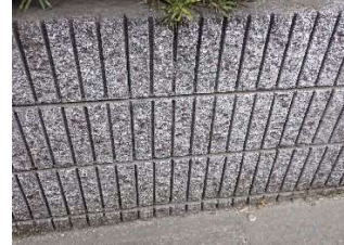
化粧ブロック塀（縦筋）
