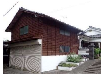
鋼製シャッター(乳白色)
