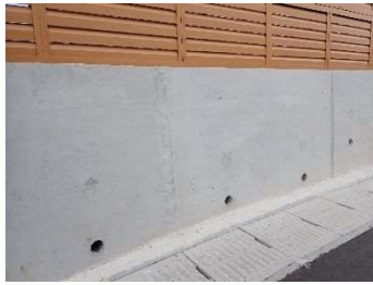
コンクリート擁壁
