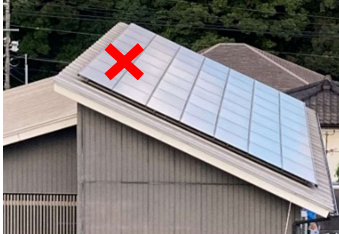
太陽光発電施設の屋上設置
