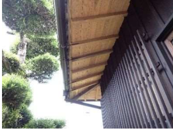
木材の軒裏の雨樋（半円型）
