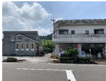
ボード吹付、コンクリート壁
