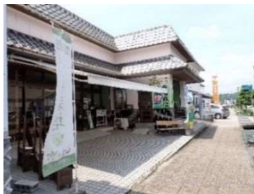
庇のみ瓦屋根
