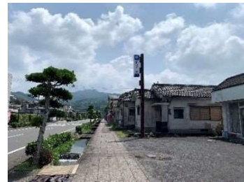
モルタル吹付の外壁
