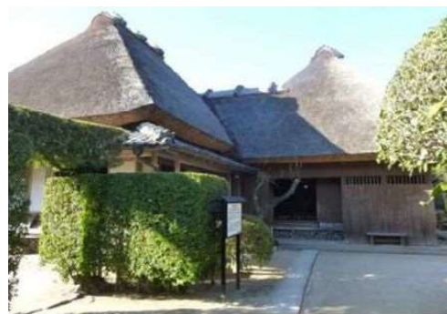
茅葺屋根・寄棟屋根（旧高城家住宅）
