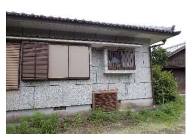
モルタル吹付
