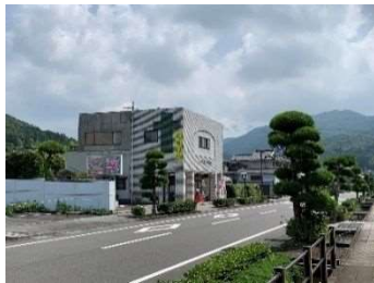
コンクリート壁
