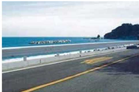
■防護柵更新前の状況
