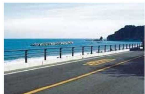
■防護柵更新後の状況
