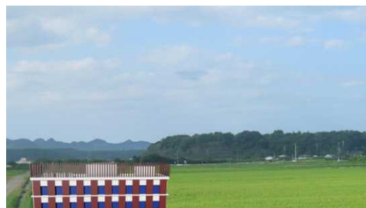
屋上の室外機等の囲いや色彩への配慮
