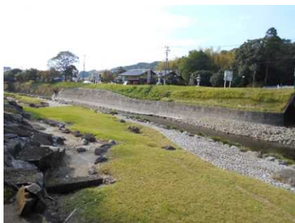
河川整備は、多自然工法を推進し、水辺に親しめる自然に近い河川景観とする
