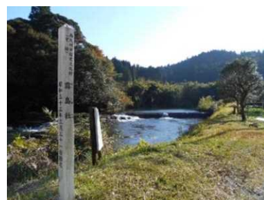
霧島社（石の井堰）
