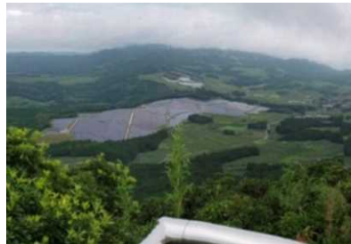
太陽光発電施設
