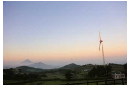
風力発電施設
