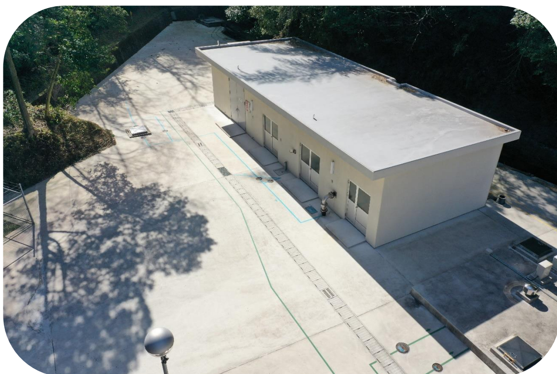
令和元年度完成 中部水源地
