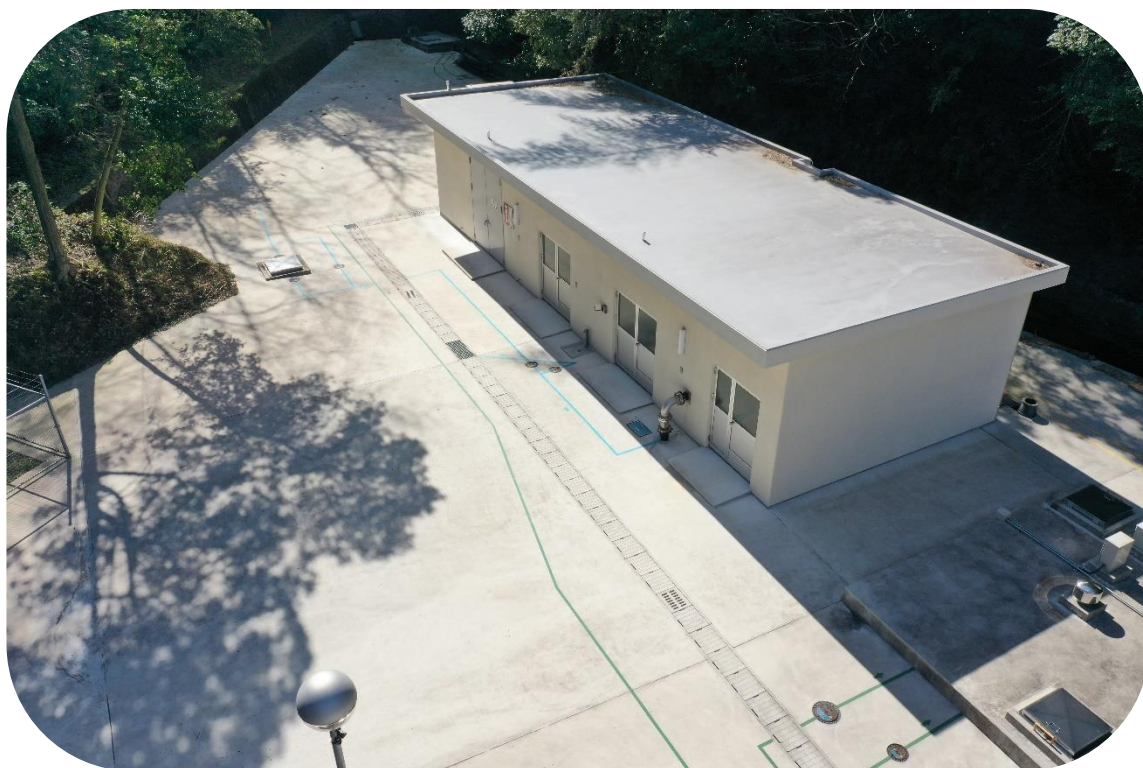
令和元年度完成 中部水源地
