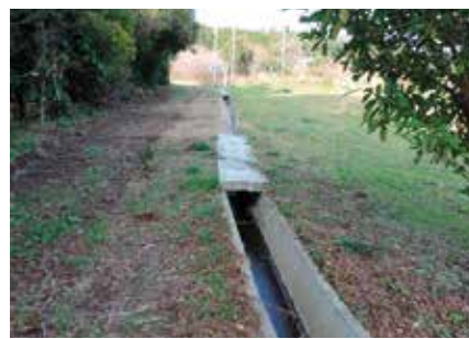
整備された排水路
