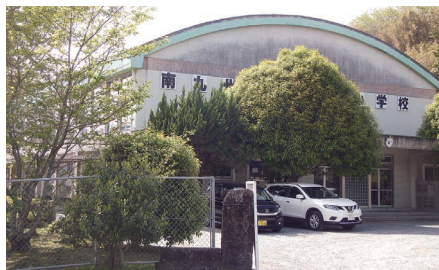
川辺小屋内運動場
