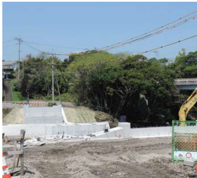
竹迫橋の架替工事
