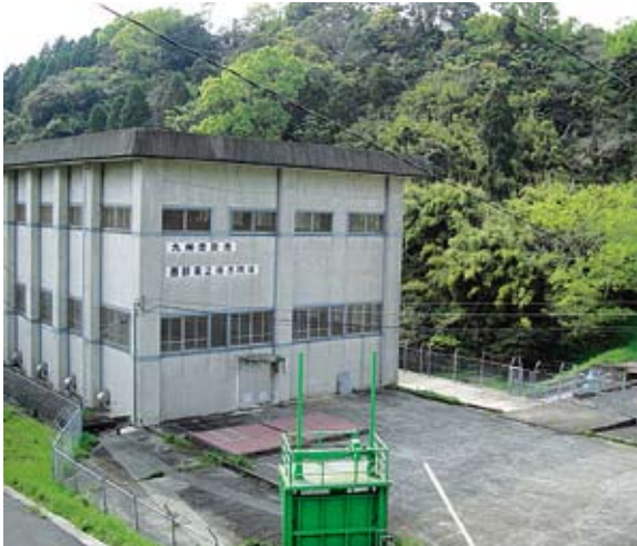
畑地かんがい西部第2揚水機場
