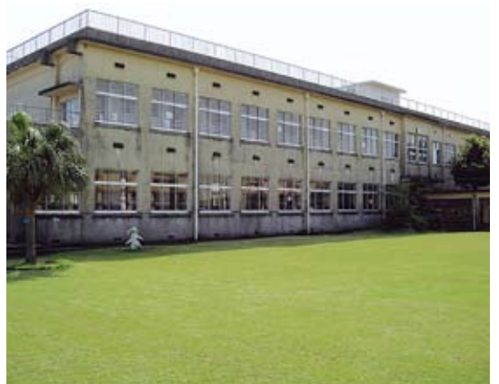
築54年経過した別府小学校
