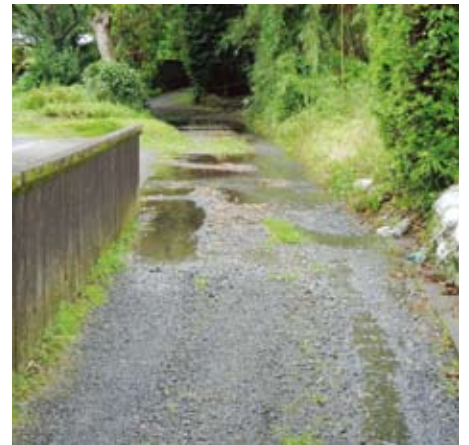
舗装予定の道路（厚地地区）
