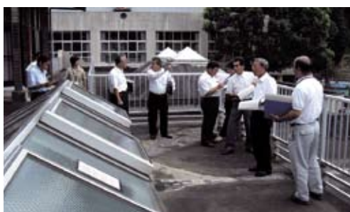
大丸小学校の天窓の現地調査をする文教厚生委員
