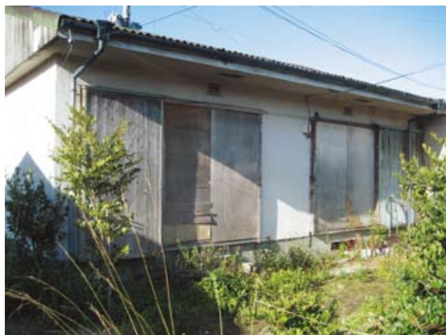
解体される牧之内団地
