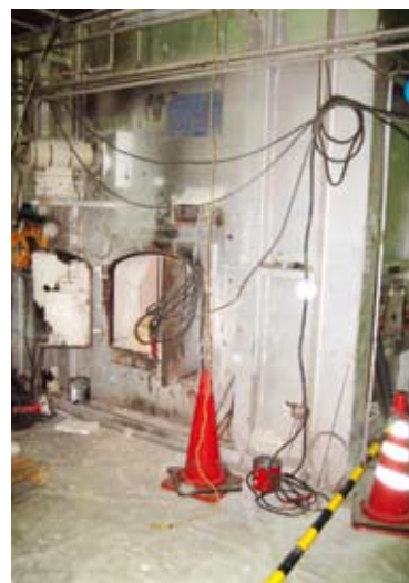
改修される焼却炉（川辺）
