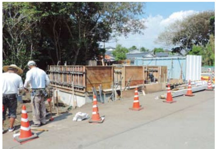
釜蓋神社近くに建設中のトイレ
