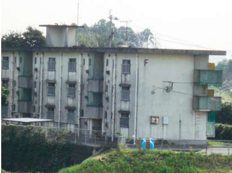
外壁・屋上防水工事などが行われる松ヶ浦団地公営住宅
