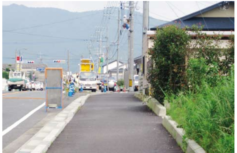
工事中の国道225号(川辺田部田)
