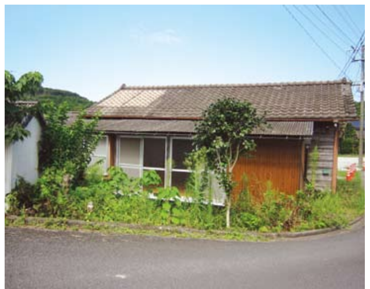
解体される両添住宅
