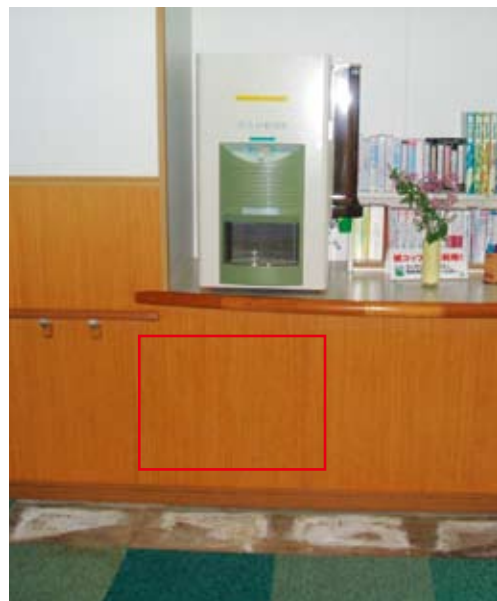
排水点検口の設置箇所
