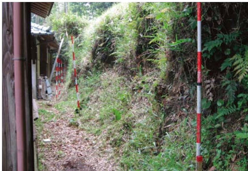
厚地塩入地区の治山工事箇所
