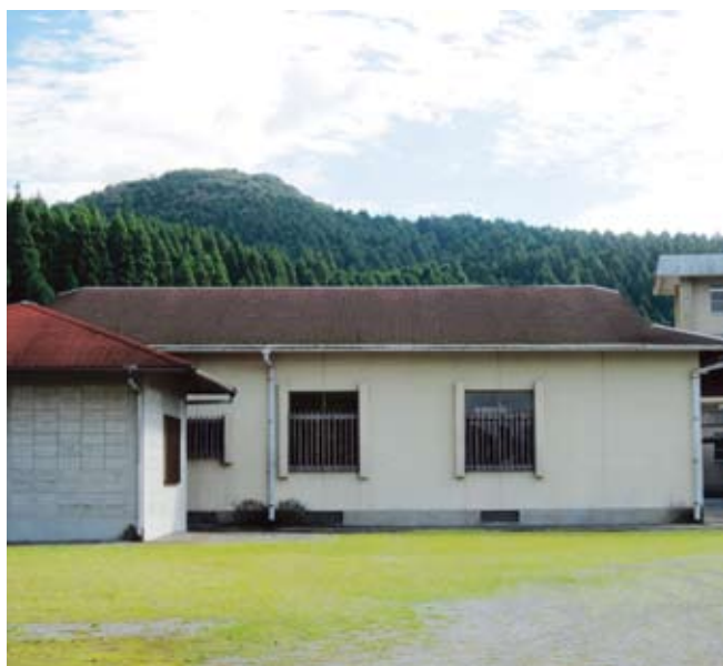
雨漏りがする川辺中弓道場
