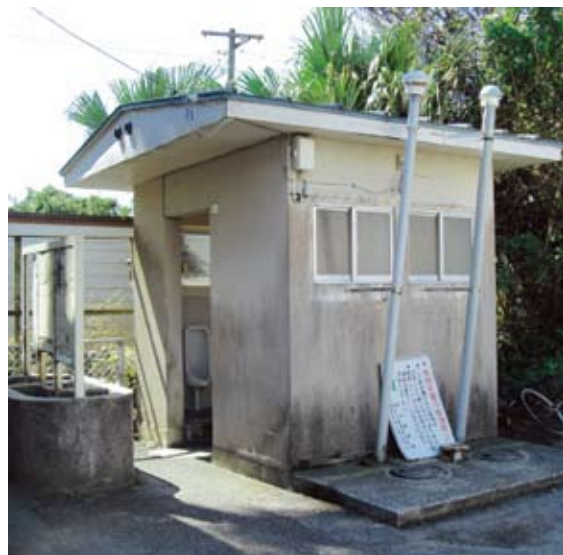
改修される西穎娃駅トイレ
