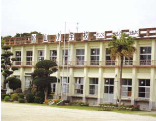
大規模改造される松山小学校校舎
