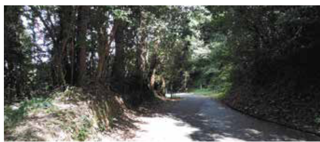
幅員が狭く見通しの悪い市道（瀬世松崎線）
