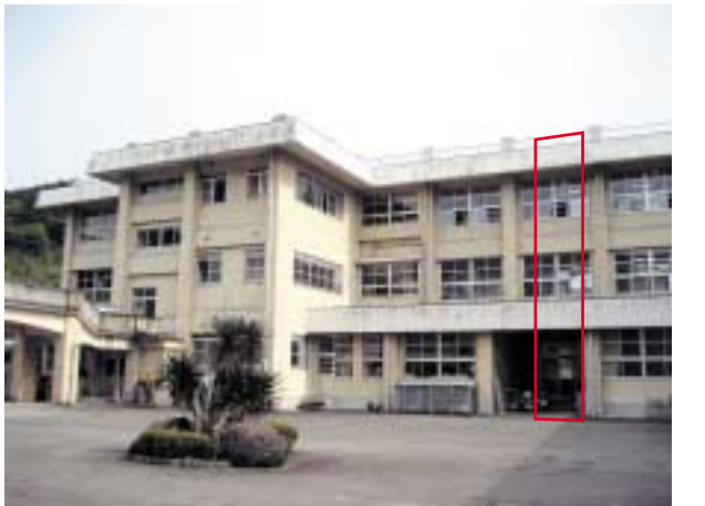
赤枠がエレベーター設置予定場所
