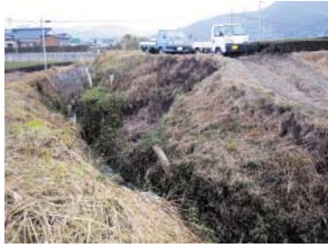
折尾地区の排水路施工箇所
