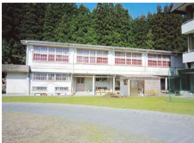
耐震改修される屋内運動場（田代小学校）
