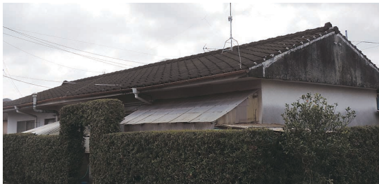
屋根工事を行う稲荷町住宅
