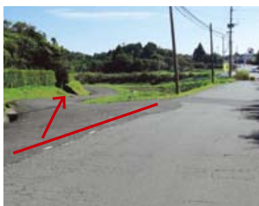
▼路線名 瀬世向建石線（認定） （延長221.5m） 知覧町瀬世字上り屋敷 字建石
