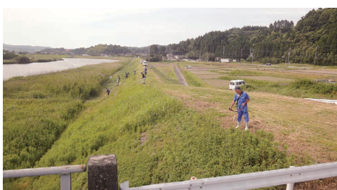
河川愛護作業の様子
