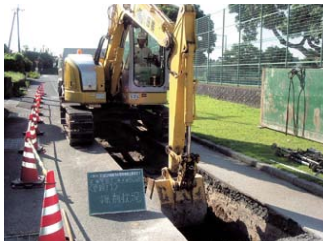
打出口地区の汚水管布設工事
