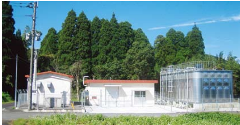
23年度に完成した配水池（西元地区）
