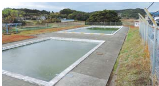
漏水のあった宮脇小学校プール
