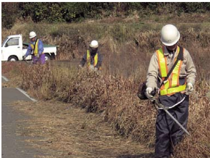
道路整備員による市道草払い
