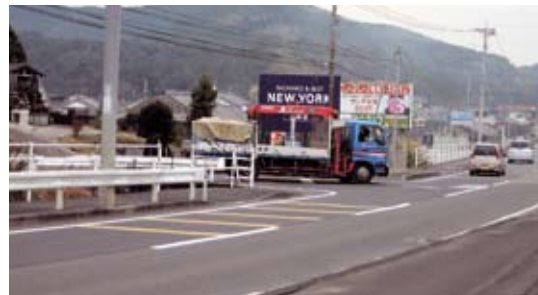
改修がまたれる勝目交差点
