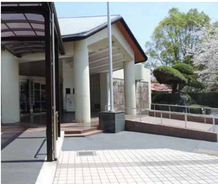
バリアフリー化された平和会館入口
