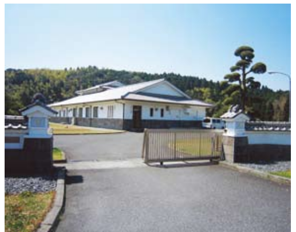
知覧中央浄化センター
