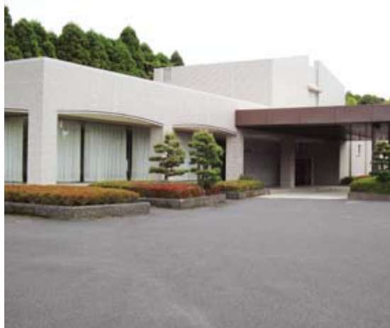
バス昇降所用屋根が設置される穎娃浄楽苑
