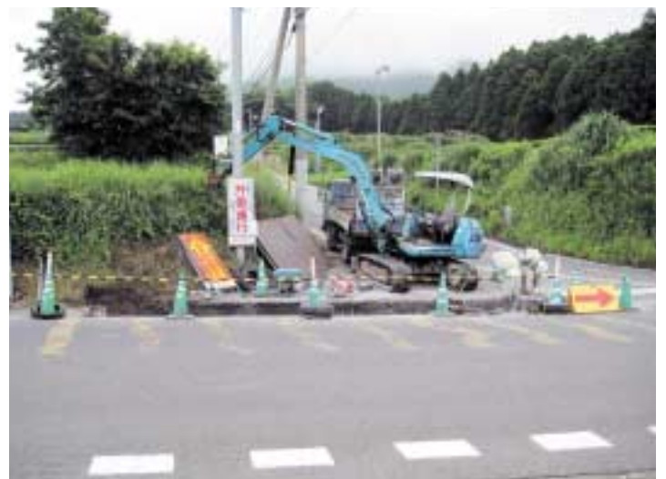
着工中の側溝整備
