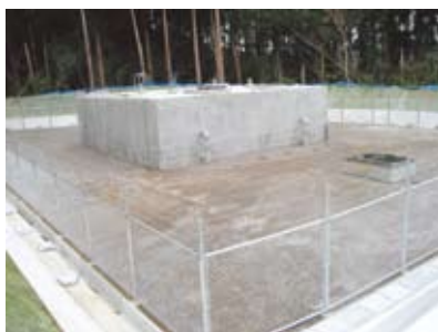
嶽地区配水池
