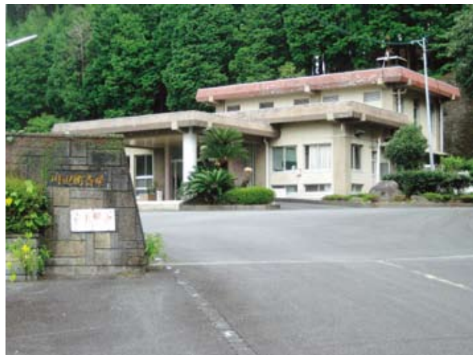
老朽化が著しい川辺火葬場
