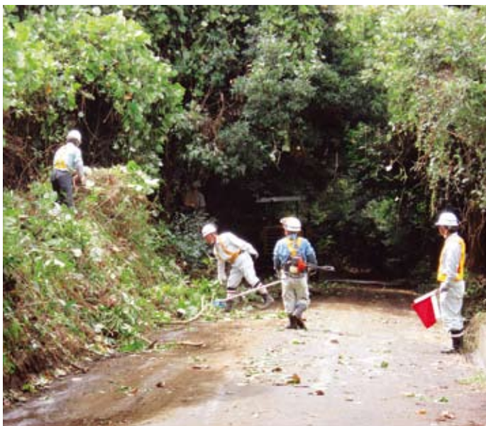
市道の草払いを行う作業員
