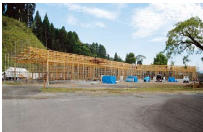
建設中の（仮称）勝目保育所
