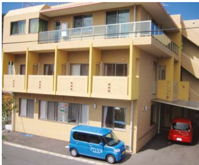
新設された民間の介護施設
