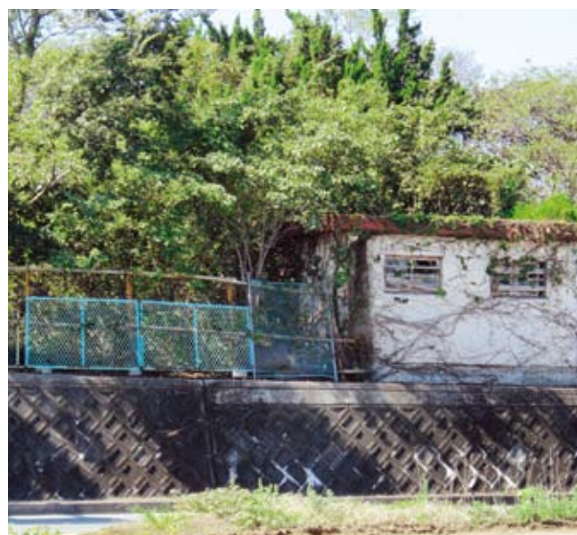
雑木が繁茂している旧プール
