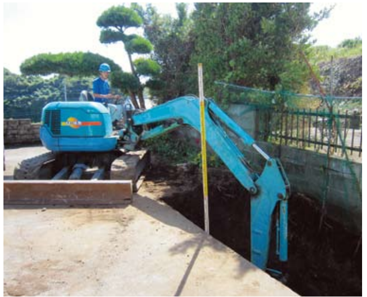
地元業者による浄化槽設置工事
