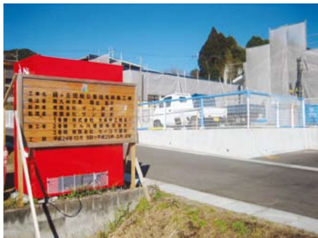
川辺地域に建設中の市営住宅
