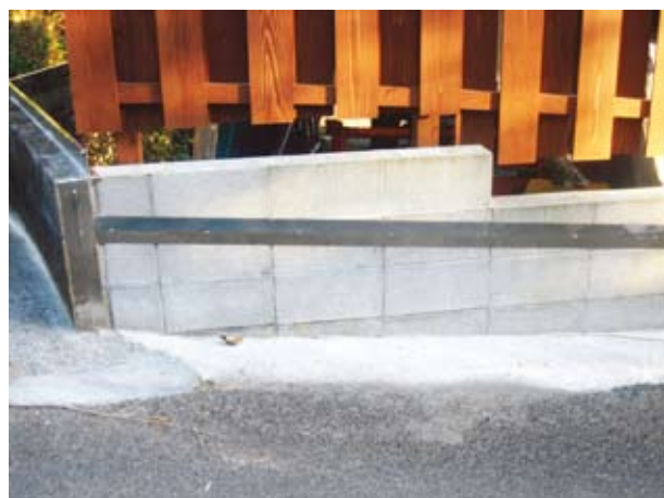
民家に設置されているヤスデ返し
