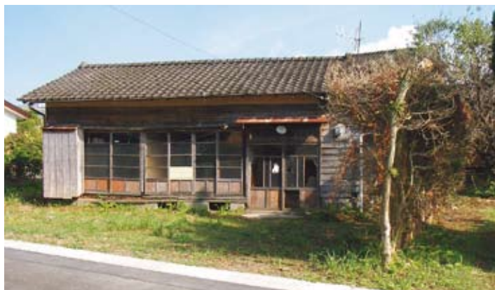
空き家となった住宅
