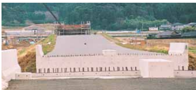
工事中の南薩縦貫道
