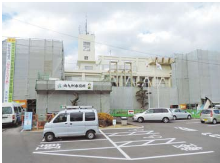
耐震改修中の知覧庁舎
