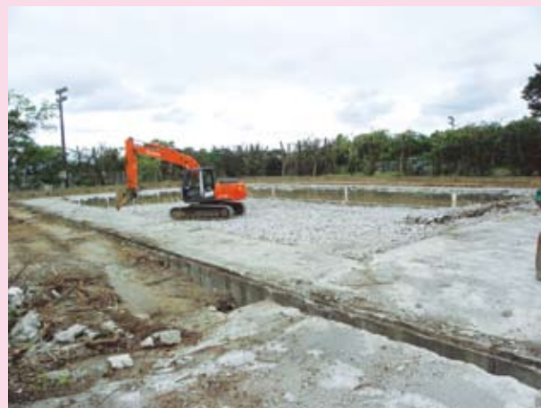
埋設工事中のプール
