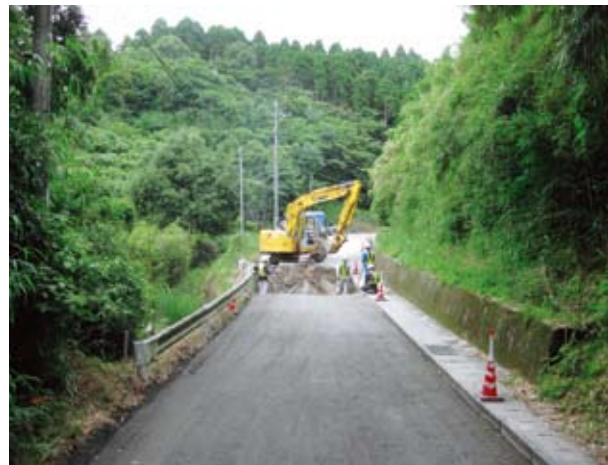
工事が進められる市道補装補修工事
