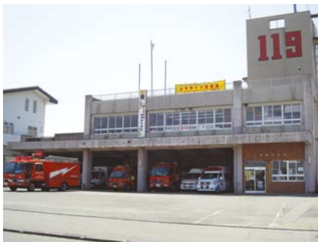
南薩地区消防組合本部（枕崎市）
