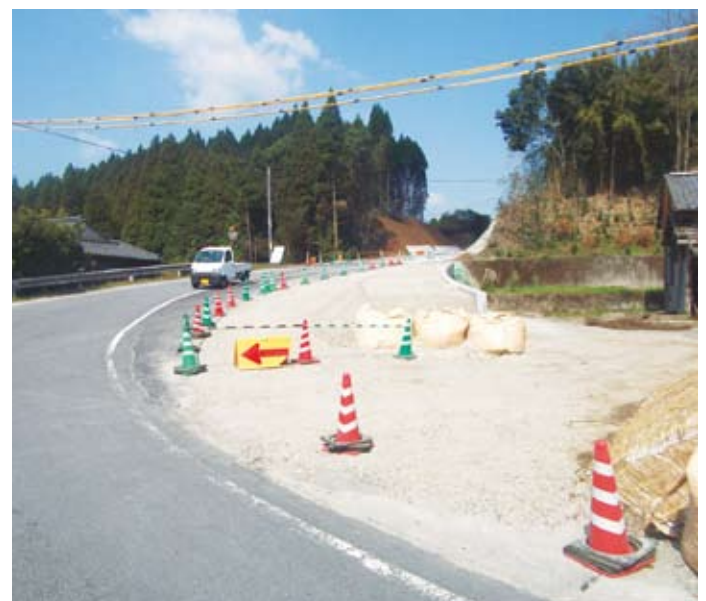
改良が進む幹線道路（柳地区）
