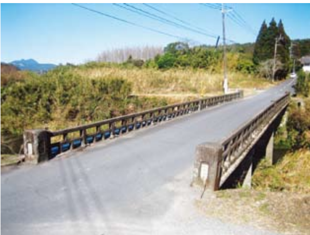
整備が待たれる橋梁
