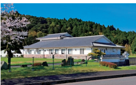
知覧中央浄化センター
