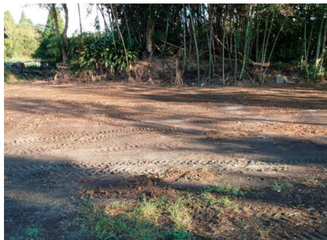
解体後の更地
