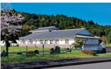
知覧中央浄化センター
