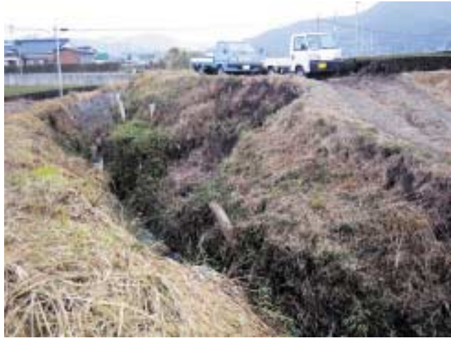
折尾地区の排水路施工箇所
