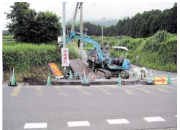
着工中の側溝整備
