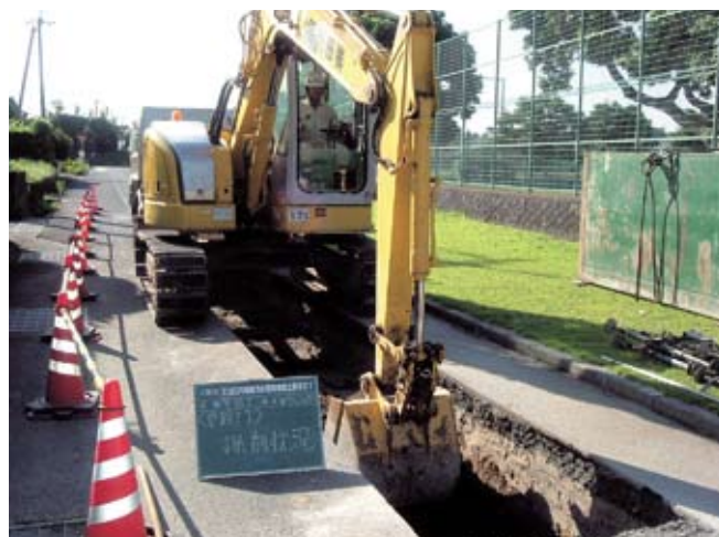
打出口地区の汚水管布設工事
